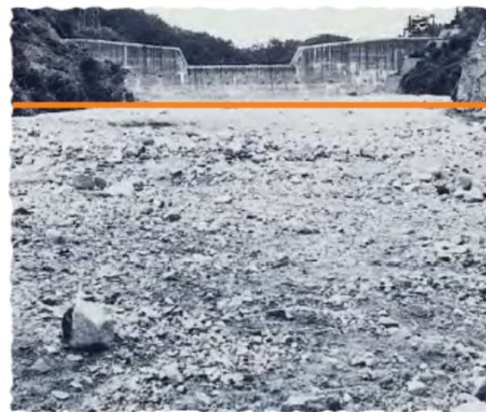
災害後(12万 m 3 の土石流を貯留)
