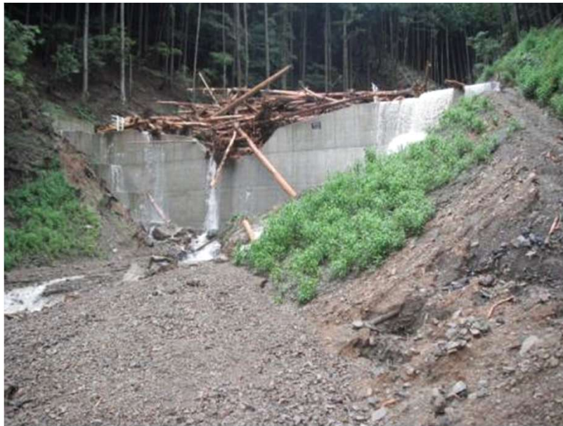
流木を補足した治山ダム 兵庫県ホームページ
